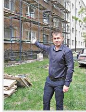
Прораб Андрей НИКОЛАЕВ рассказал, чем после ремонта пятиэтажки на ул. Араканцева будет выгодно отличаться от других.
