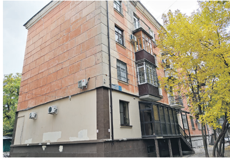
Сегодня в доме идёт ремонт фасада, фундамента и подвала.
