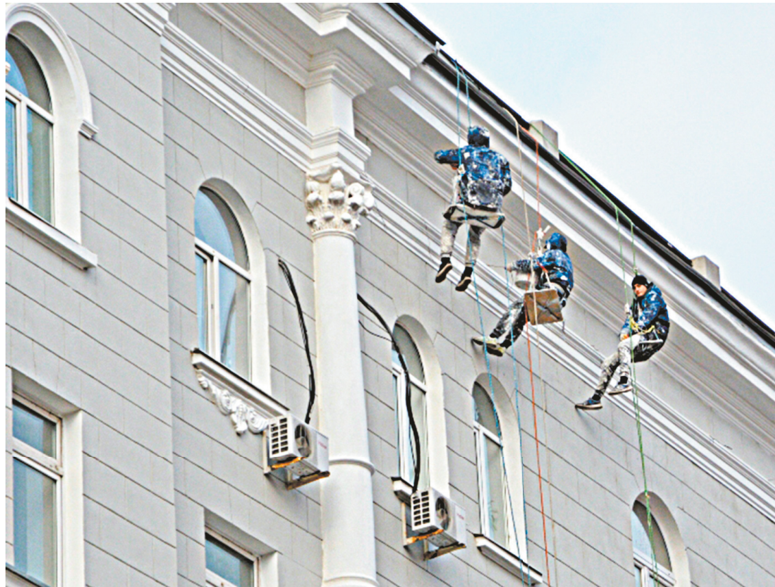
В этом году запланировано провести капитальный ремонт в 1305 многоквартирных домах, из них в донской столице — в 544. Продолжается капитальный ремонт более чем на 800 объектах.
