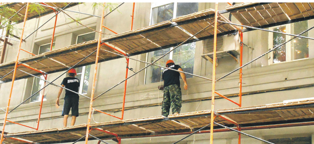
Капремонт доверяют подрядчикам, прошедшим двухуровневую систему отбора.
