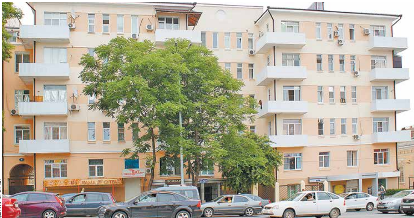
Жилой дом 1928 года постройки на проспекте Ворошилова, 8 (Ростов-на-Дону) отремонтирован с использованием энергоэффективных технологий
