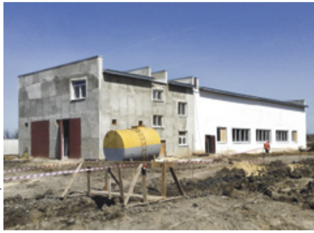
■ Завершено строительство насосной станции «Майская»
